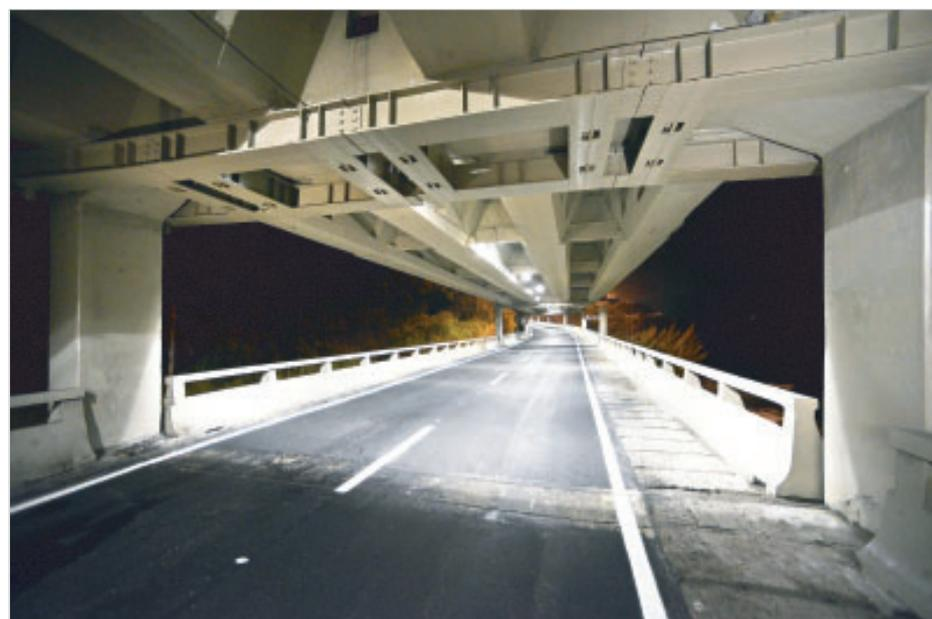
ainda barreiras de concreto do tipo "New Jersey". O local também está com placas próprias de revestimento que foram tratadas com tinta antipichação, na cor branca. Nesse caso, o intuito foi potencializar a claridade no interior dos túneis. Além disto, a iluminação local também foi toda revitalizada.
